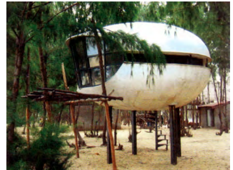
Pascal Häusermann, Pavillon, Pullicat, 2000 Vue du chantier
