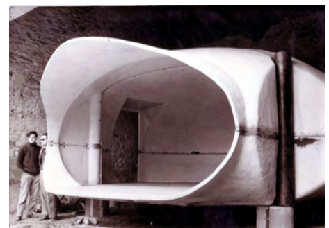
Pascal Häusermann, Habitation Noverly , 1963-1966 Vues du moulage et de l'assemblage des pièces au château de Noverly, Minzier, 1963
