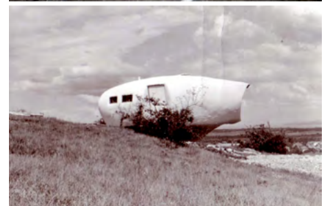
Pascal Häusermann, Pavillon expérimental du week-end, Grilly, 1958 Vues du chantier de construction, Grilly, 1958
